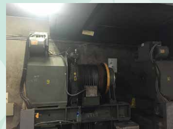
已更換之升降機鋼纜 New hoisting ropes
