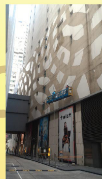
使用吊船作外牆及 外牆玻璃檢查
