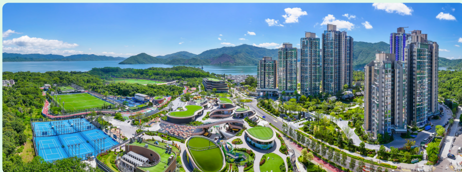
採用階梯式設計的住宅大樓
