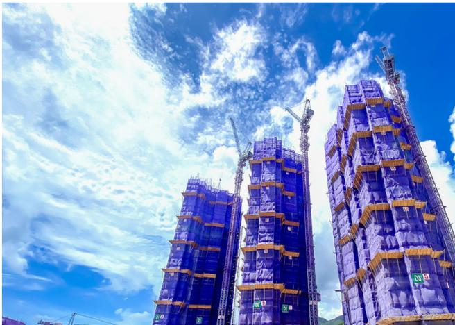
在西沙發展項目中應用防撞系統並設置5G遙遠控制天秤系統
