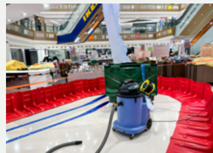
使用 660 公升的容器及潛水泵排水
