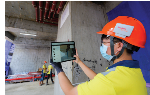
• 建築工人佩戴了配備物聯網感應器及GPS追蹤器的智能頭盔
