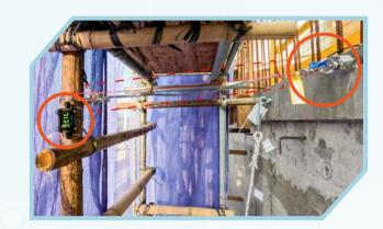
棚架是建築工程的重要一環。過往棚架的安全監察倚賴 人手巡查,花費不少時間和人力。由新輝建築創科自主 研發的全港首個智能棚架監測系統TIE.Ai,結合人工智 能、物聯網與精密傳感技術,實時監測棚架,解決傳統 人工巡查效率低、隱患發現滯後的缺點,顯著提升工地 安全。
