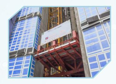
要築起繁華的天際線,建築團隊需要擁有高水平的高空施工能力。新輝在興建啟德城中心住宅項目天璽·天的過程中,為了建造高層住宅單位、空中花園及避難層,團隊需在約28層樓的高處、五座樓宇的夾縫之間建造工作台。惟傳統方法不僅耗時兼成本高,難以配合建造後續外牆工程的需要,工友在高空作業時更存在安全風險。
