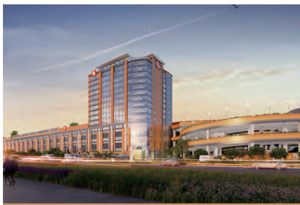
○ 香港機場空運中心
