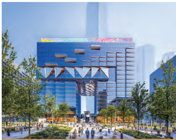
○ 西九龍藝術廣場大樓項目
