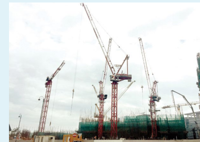
• 天秤防撞系統已在我們的工地廣泛使用以提高安全性
